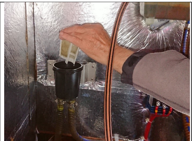
Filter udtages og kontrolleres/renses
